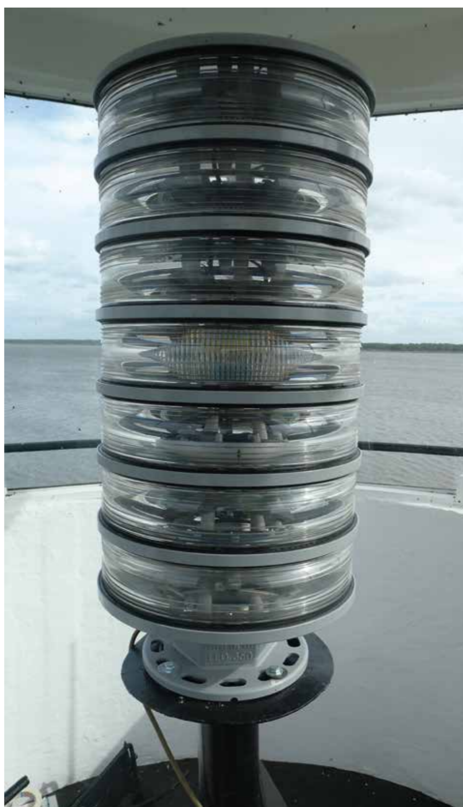
Первый светодиодный фонарь маяка: круговая лампа Sabik LED-350-7W на маяке Мехикоорма, фото Т. Вилу
