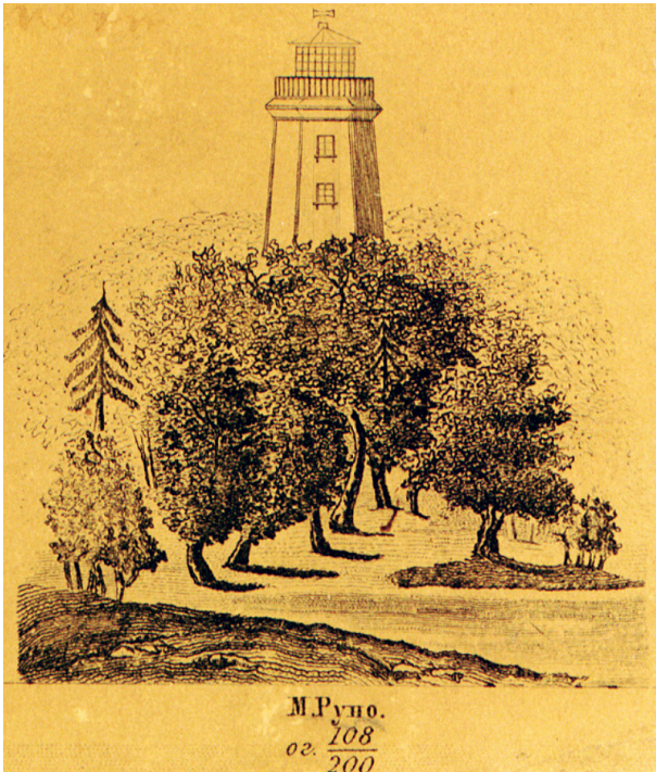
Kuuetahuline puittuletorn Håubjärrel, 1862
