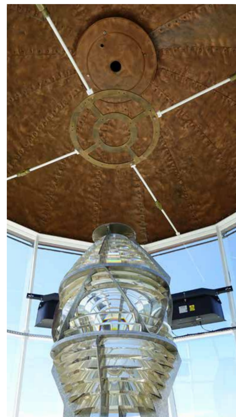
На переднем плане – осветительное устройство Chance Brothers & Co, установленное в 1870 году, на заднем плане – современные фонари системы освещения Sabik, фото 2021 года, Т.Вилу
