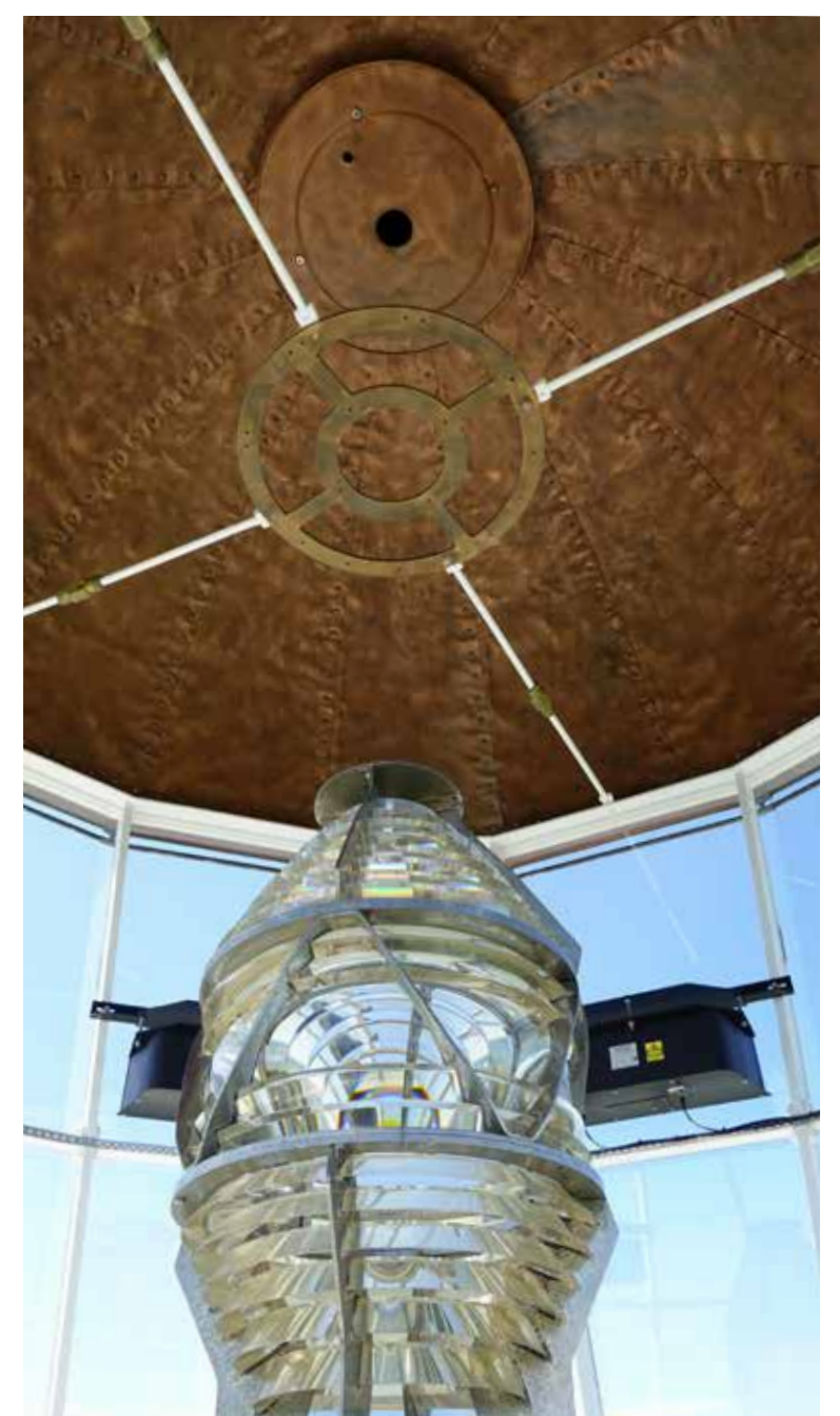
Esiplaanil aastal 1870 paigaldatud Chance Brothers & Co tuleseade, tagaplaanil modernsed Sabik tulesüsteemi laternad, foto aastast 2021, T. Vilu
