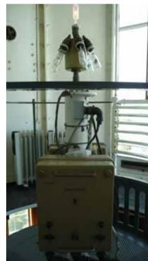
Заменитель ламп с галогенными лампами мощностью 1000 Вт перед линзой Френеля, фото 2009 г., В. Лайтус
