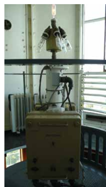
Lambivahetaja 1000 W halogeenpirnidega Fresneli lääitse ees, foto aastast 2009, V. Laitus
