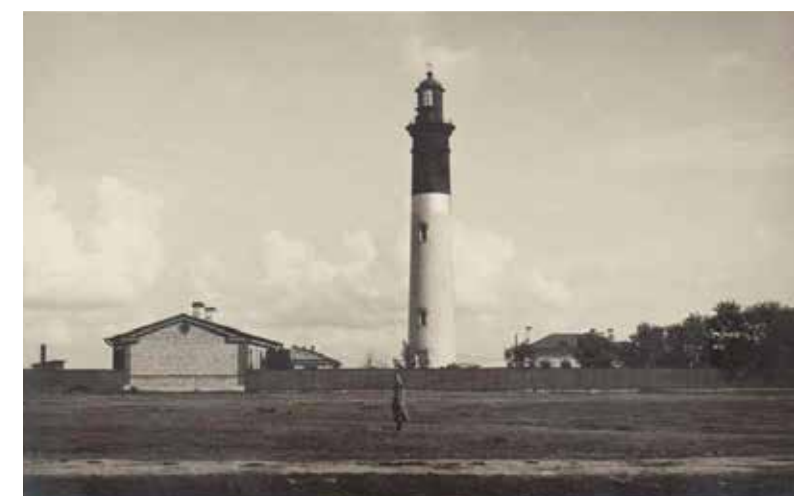
Tuletornikompleks 20. saj alguses – vaade loodest
