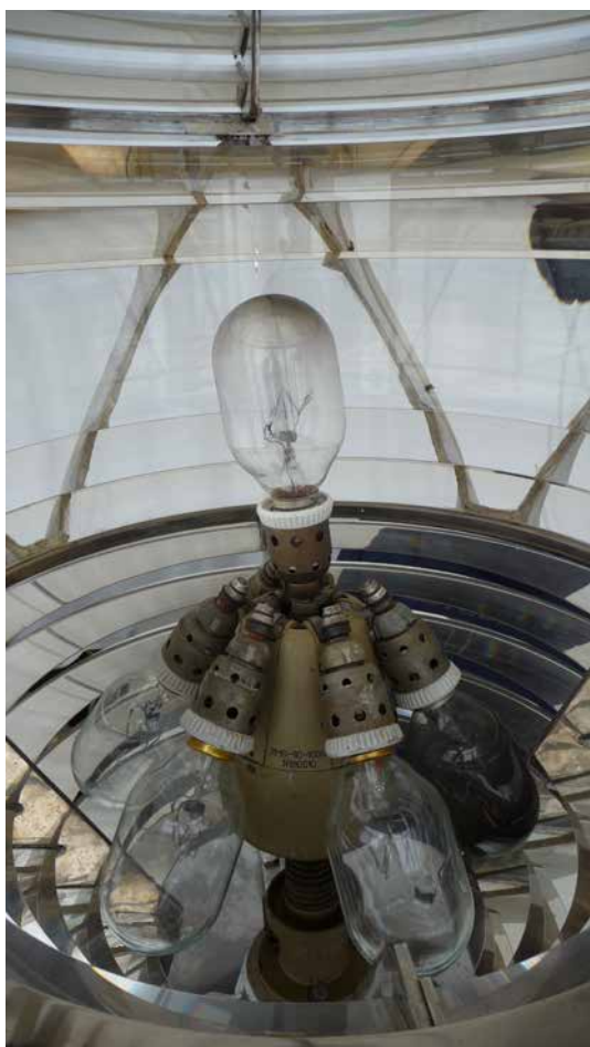
Лампоменяющее устройство системы света EMN-500 в диоптрической линзе Френеля, фото В. Лаитус
