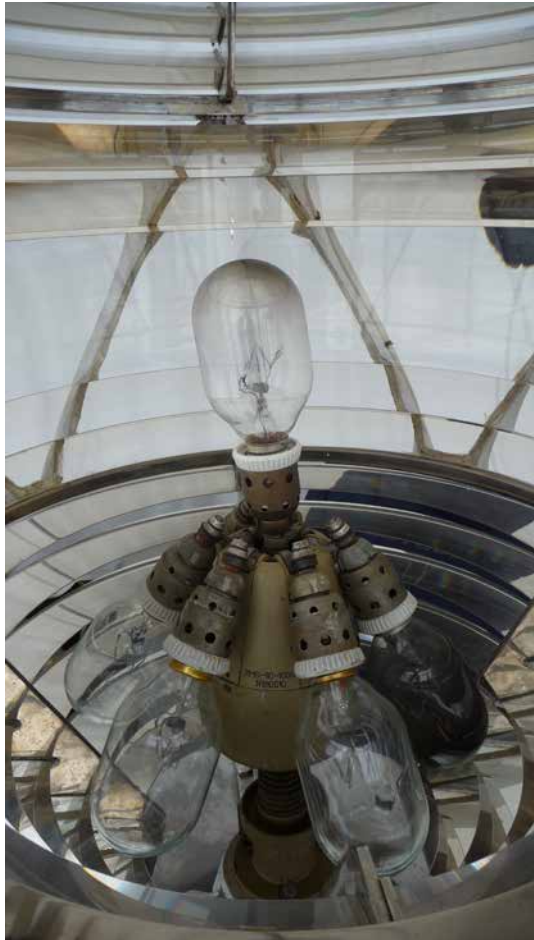
EMN-500 tulesüsteemi lambivahetaja Fresneli dioptrilises klaasläätstes, foto V. Laitus
